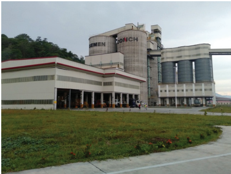
Pabrik semen Conch yang terletak di jalan Trans Sulawesi, Desa Solog, Kecamatan Lolak, Kabupaten Bolmong. Foto: Neno Karlina.
