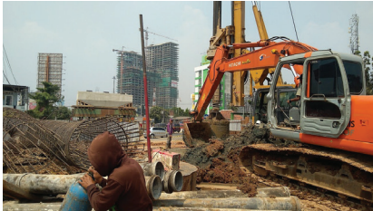
Aktivitas pekerja proyek PT Intan Cipta Perdana dalam proses pembangunan pondasi jembatan layang di perempatan Jalan Rawa Panjang, Bekasi, Jawa Barat, Senin 30 Juli 2018. (Foto: Melki Pangaribuan)
