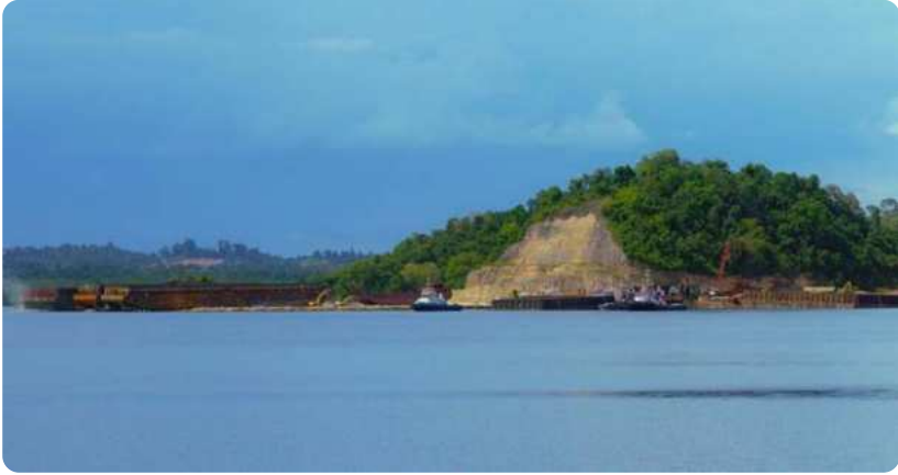
Pelabuhan (jetty) perusahaan tambang nikel yang beroperasi di Desa Torobulu, Kecamatan Laeya, Kabupaten Konawe Selatan (Konsel), Sulawesi Tenggara (Sultra). Foto: La Ode Risman Hermawan/Kendariinfo. (28/2/2025).
