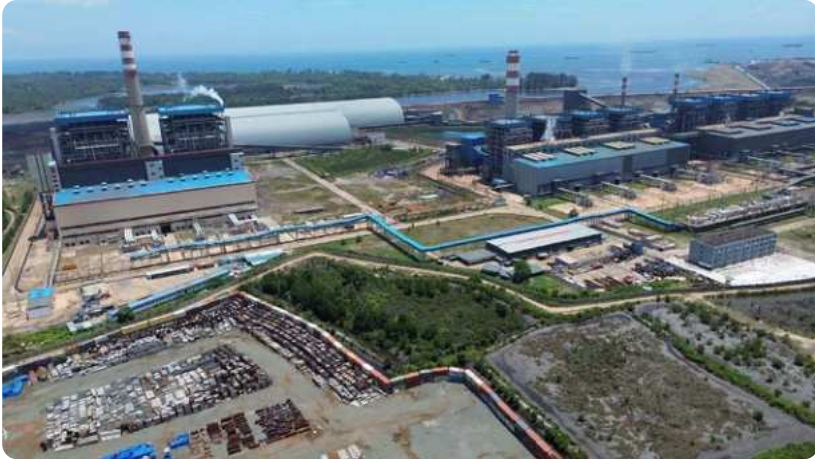
Pembangkit Listrik Tenaga Uap (PLTU) Captive PT Obsidian Stainless Steel (OSS) yang terletak di Desa Tani Indah, Kecamatan Kapoiala, Kabupaten Konawe, Sulawesi Tenggara. Foto : Istimewa
